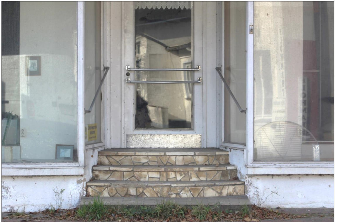
Abbildung 5: Detailsicht Fassade Hauptgebäude
