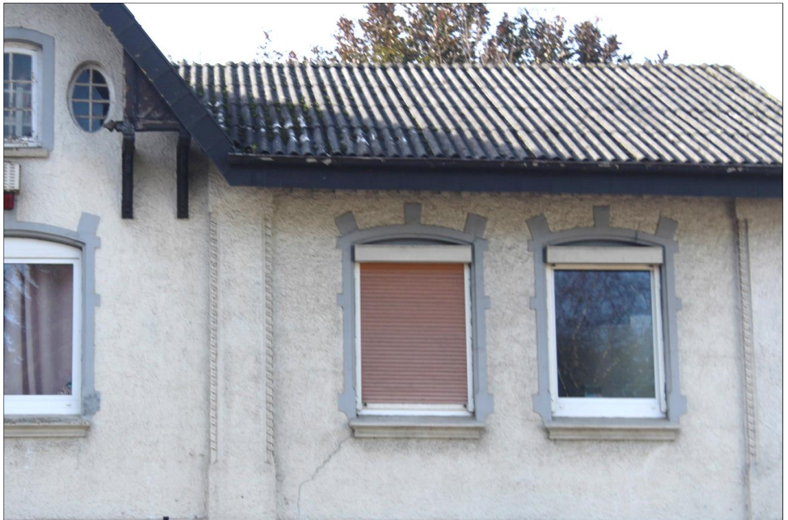
Abbildung 5: Ausschnitt Fassade Hauptgebäude
