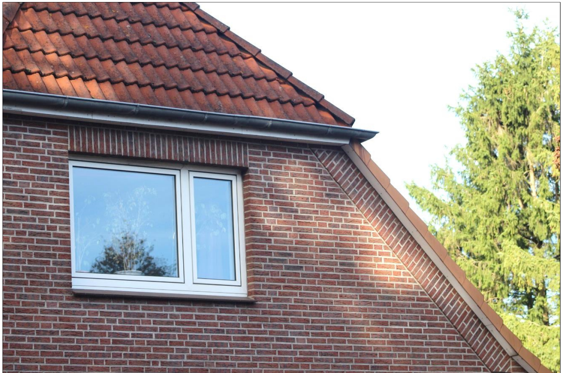
Abbildung 5: Detailansicht Fassade Hauptgebäude
