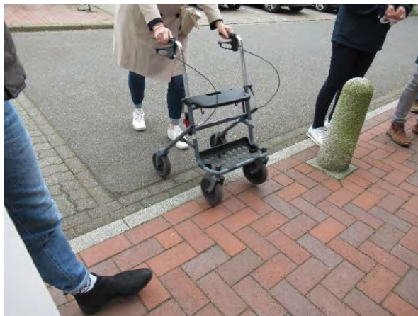
1b) Kante von der Asphaltstraße zum Fußweg
