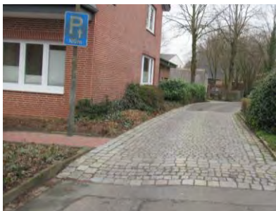
2b) Aufpflasterung Straße Zum Park
