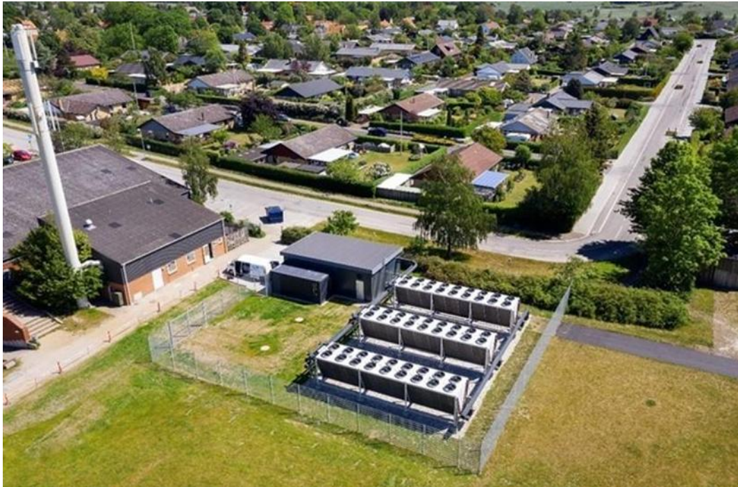
Abbildung 32: 1,2 MW Luft-Wärmepumpe in Slagslund Dänemark (Quelle: PlanEnergi)
